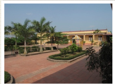
DER NEUE KINDERGARTEN IN TANTRUNG AN TRU
